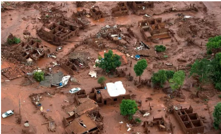
Rompimento de barragem em Mariana/MG
