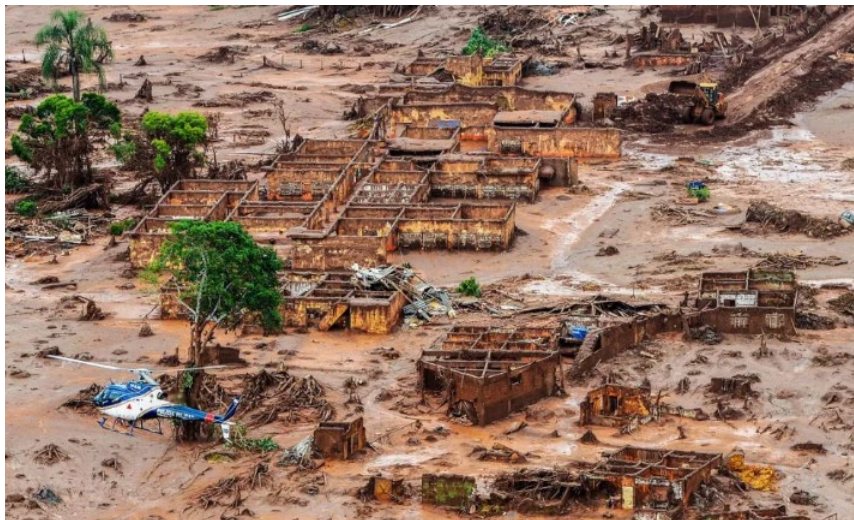
Rompimento de barragem em Brumadinho/BH
